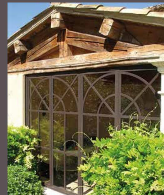
Créée en 1969 la ferronnerie ROVERY s'est spécialisée depuis plus de 10 ans dans la fabrication de menuiseries acier hautes performances. Les différents profilés et vitrages utilisés aujourd'hui permettent d'allier la finesse, la solidité et la rupture de pont thermique. Les performances énergétiques obtenues répondent aux exigences et aux nouvelles normes du bâtiment imposées par la RT2012.
